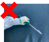
法尻から斜め上に向けて打設
