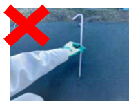
法肩から下に向けて打設
