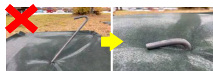
立たせすぎた状態で打設
