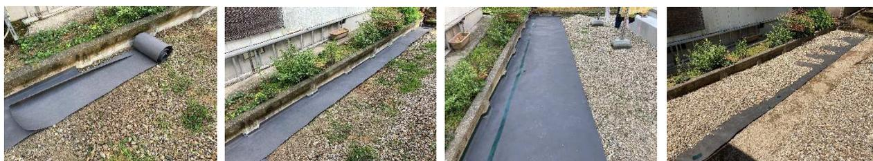
防草シートを10cm立ち上げ擁壁に沿って設置 → 粘着テープで端部を保護 → 碎石を載せて完了
