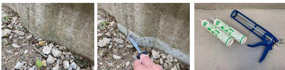
擁壁の汚れをブラシで除去（地際から10cm程） → 擁壁下部にシーリング材アタッチを塗布
